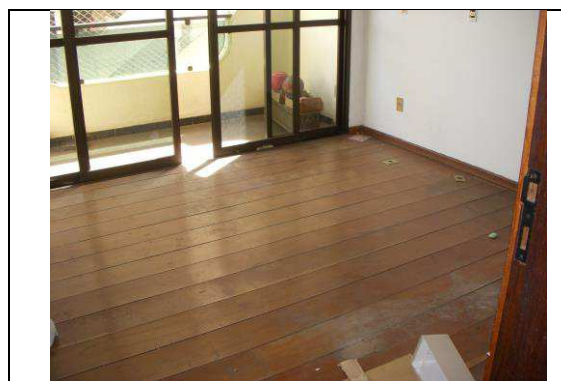
Foto 03. Vista do piso da sala.
