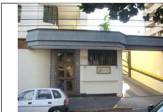
Foto 01. Vista geral da fachada do condomínio Rembrandt Plaza.
