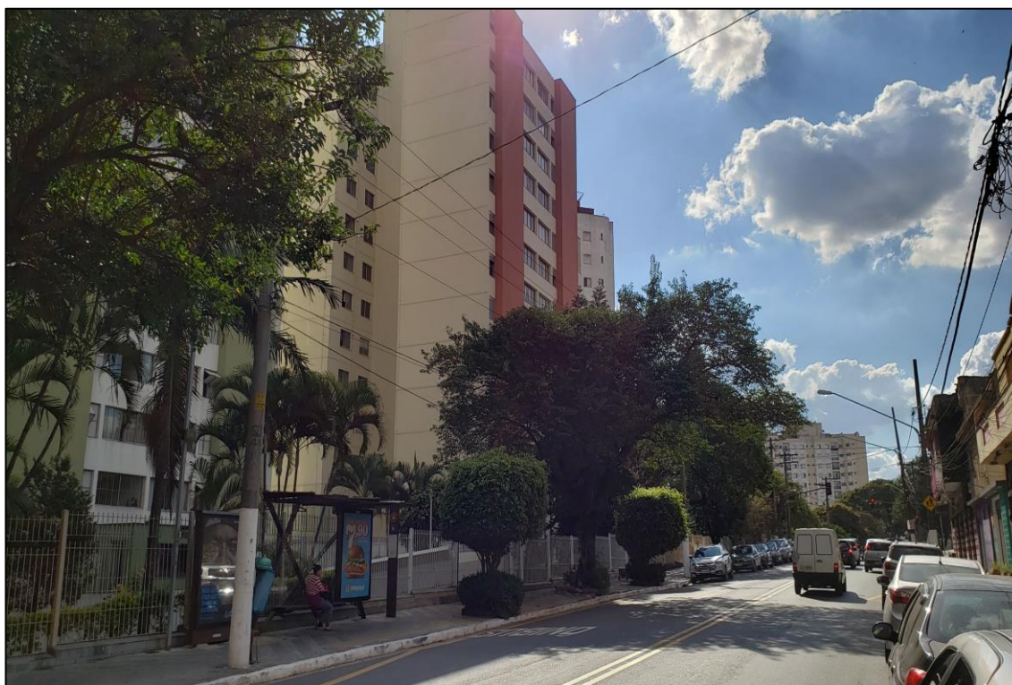
FOTO nº 02 Vista da Rua Ibitirama à direita do Condomínio Edifício Mônica.
