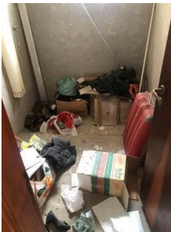
Foto 9 – Vista de banheiro inacabado
