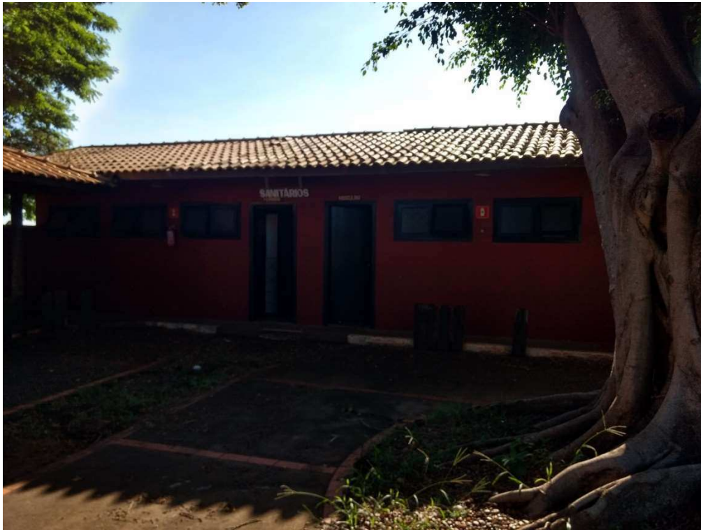
22. Vista Vestiários II
