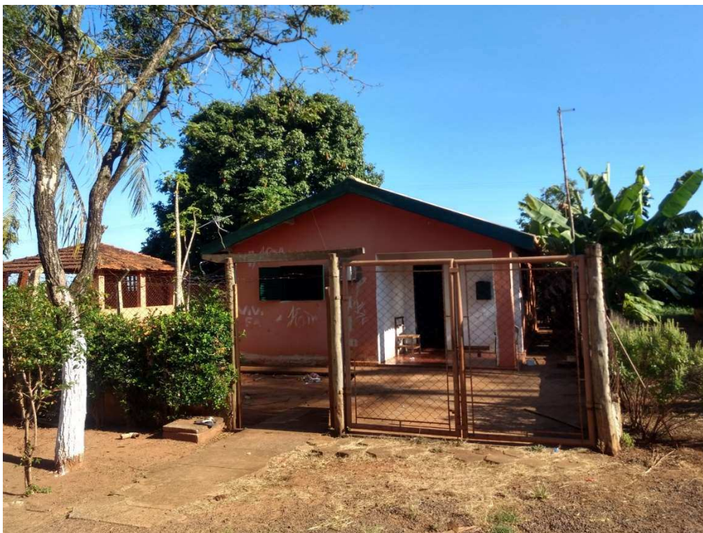
25. Vista Fachada casa de colono
