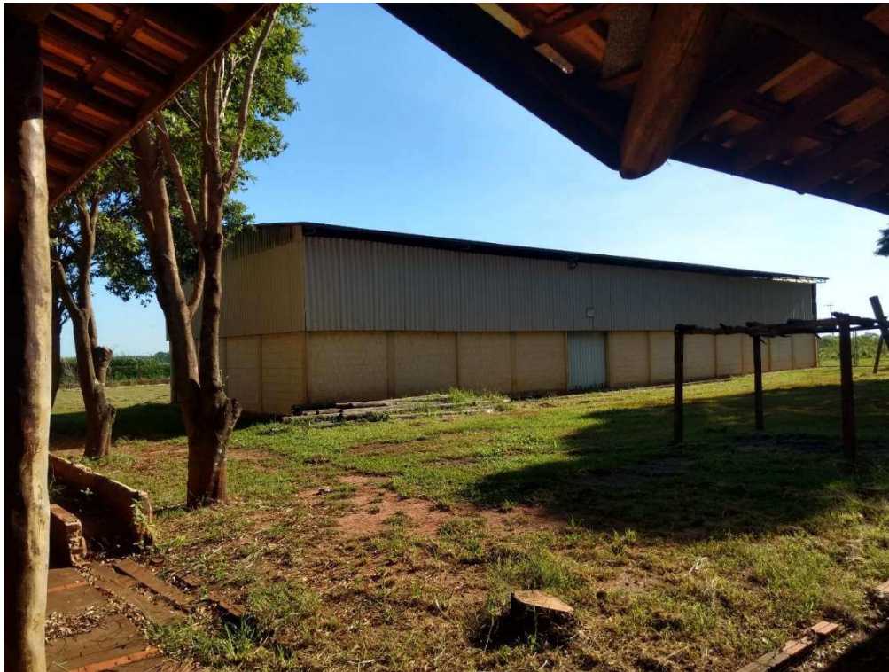
24. Vista Barracão / depósito
