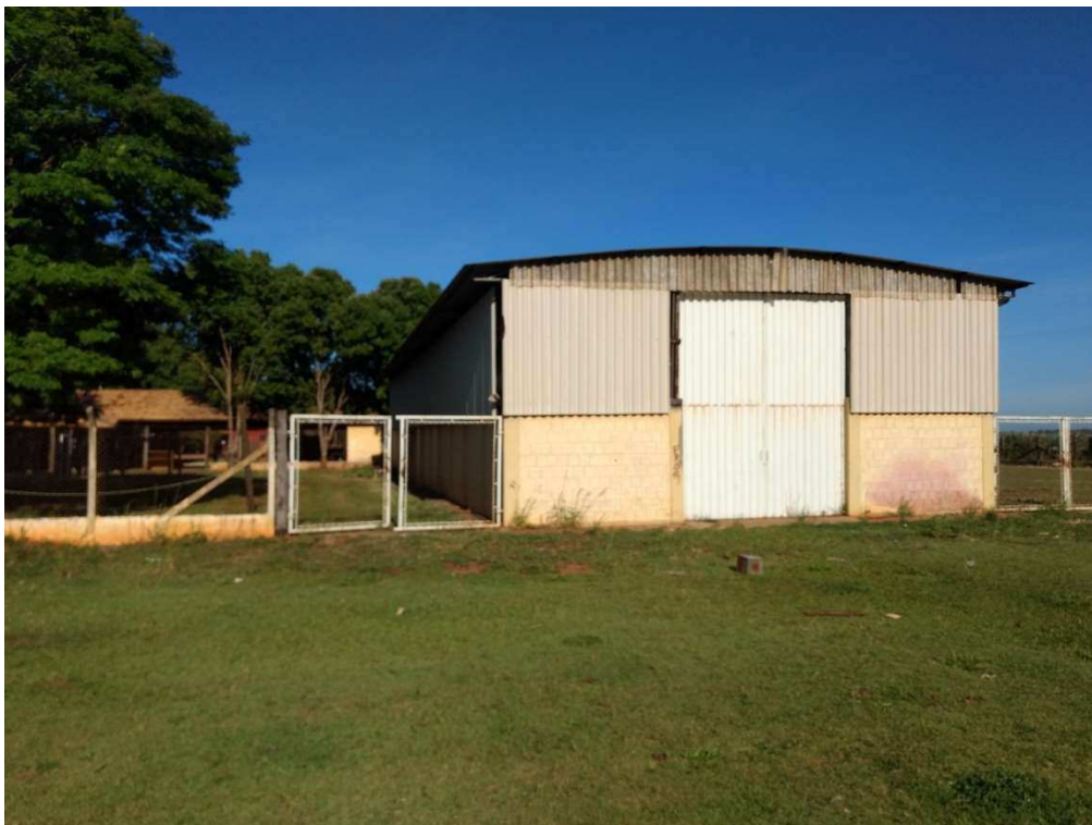
23. Vista Fachada barraca / deposito
