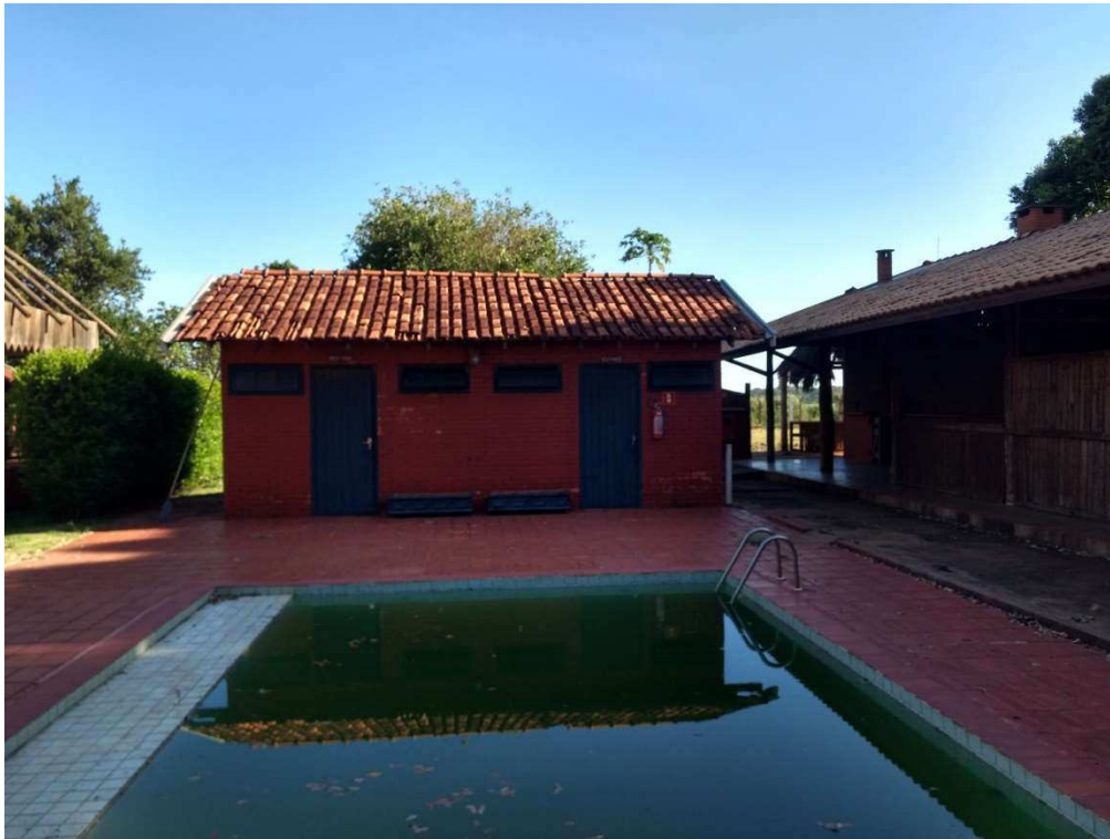
18. Vista da piscina com vestiários I
