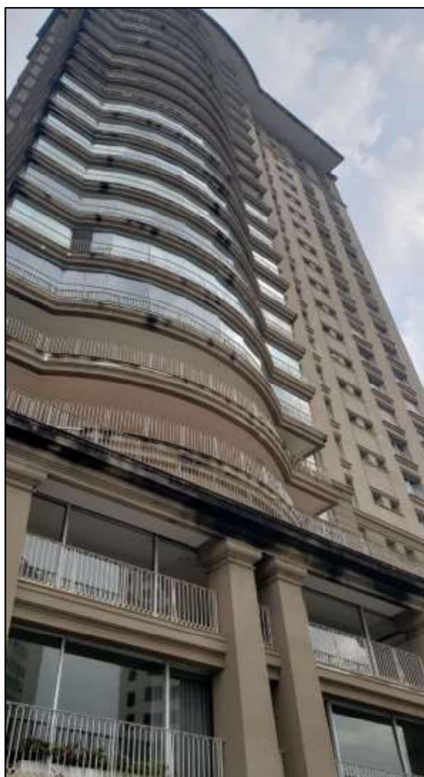
Foto 03 – Outra vista da fachada do edifício.
