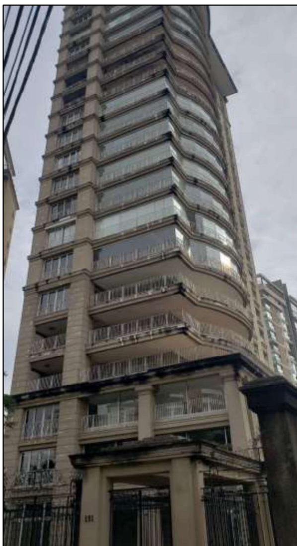
Foto 02 – Vista da fachada do edifício.
