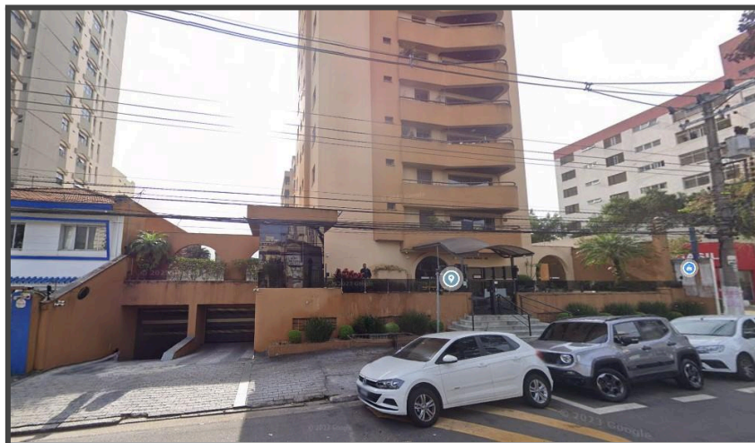
Fachada do prédio
