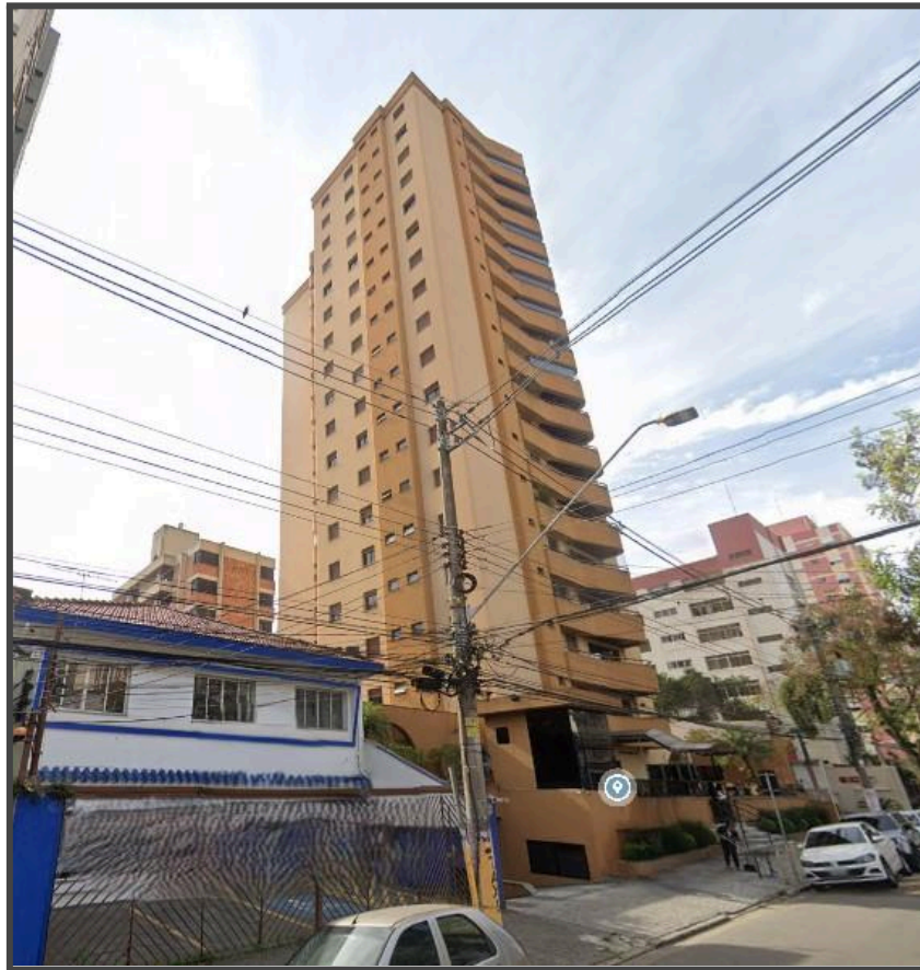
Fachada do prédio
