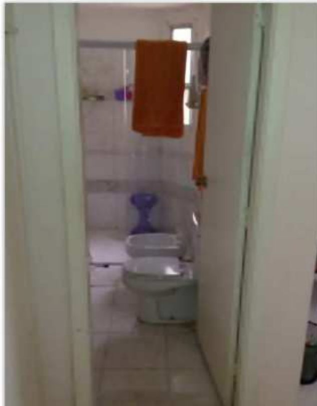
Foto 15 - Vista do segundo banheiro.
