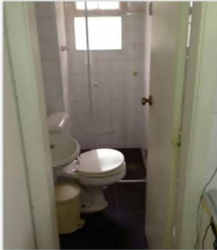
Foto 09 - Vista do banheiro de funcionária.
