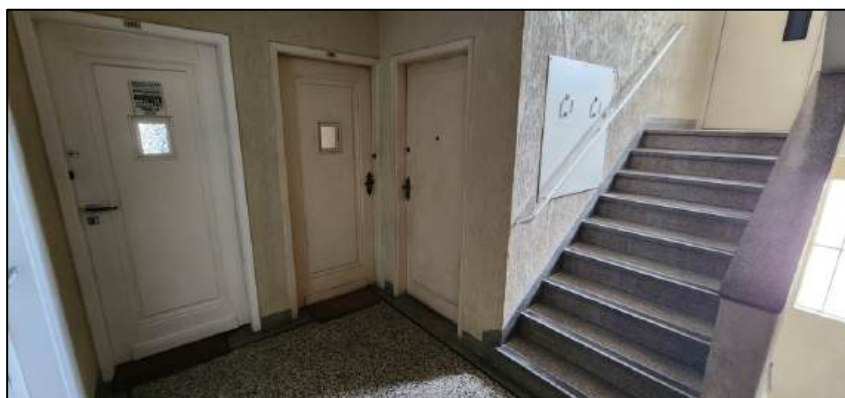
Foto 04 – Hall no andar
