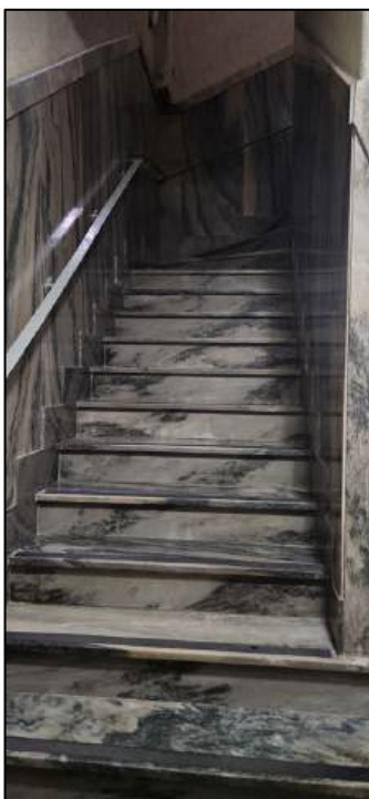
Foto 03 – Escada de acesso
