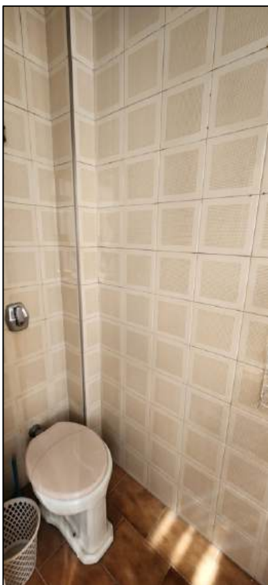
Foto 9 – Banheiro de serviço
