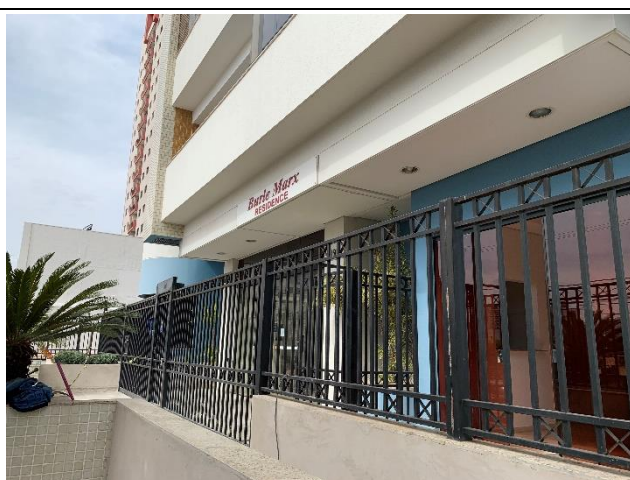
Foto 02. Vista da entrada
