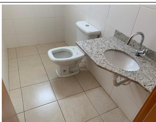
Foto 04. Vista do banheiro social.
