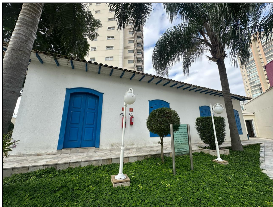
Construção Colonial datada de 1856
