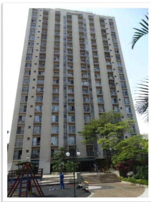
Foto nº 51 - Aspectos gerais do Condomínio Prive Cidade Jardim – Vista da Fachada de Fundos do Bloco B.
