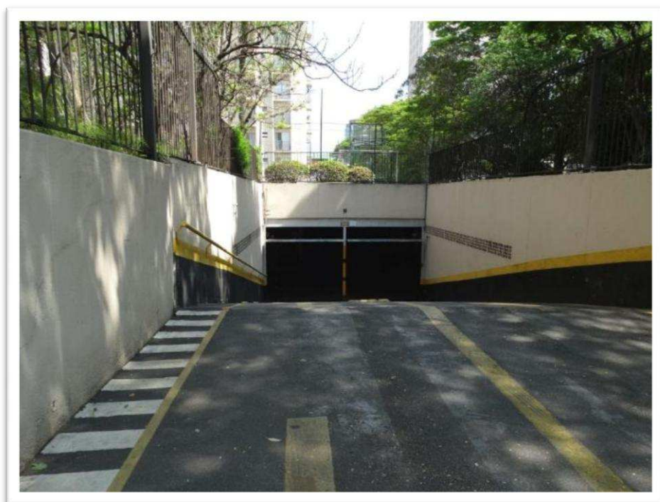
Foto nº 40 - Vista externa da rampa de acesso à garagem no subsolo do Bloco B do Condomínio Prive Cidade Jardim.
