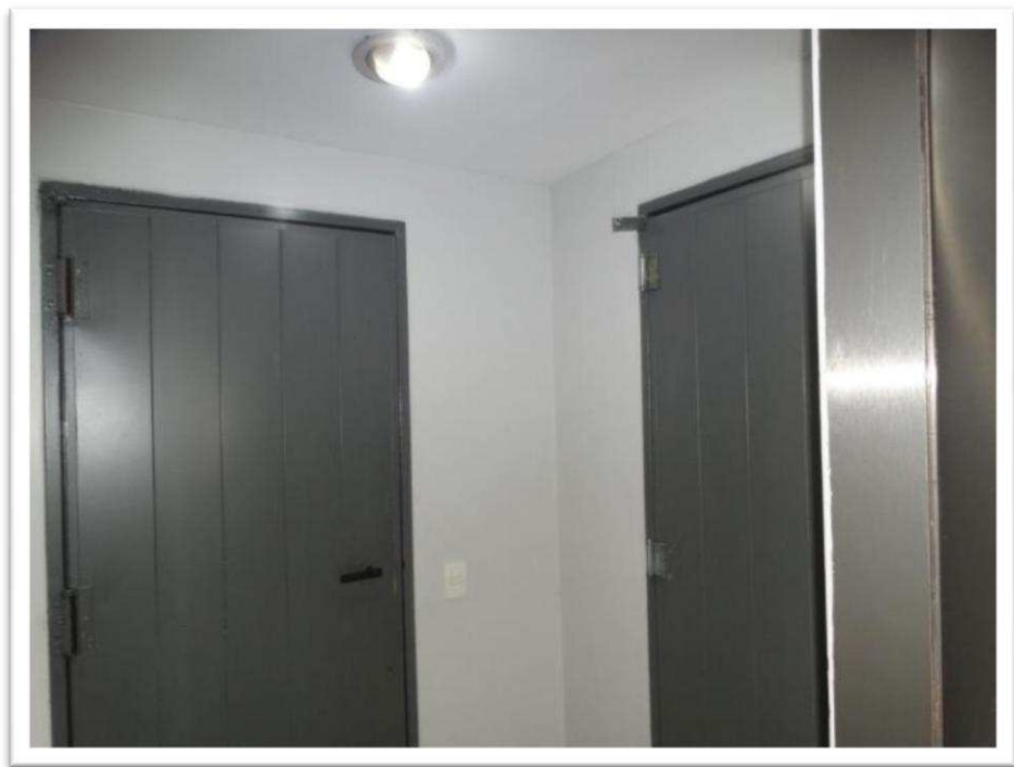
Foto nº 9 - Vista parcial do pavimento térreo do Bloco B do Condomínio Prive Cidade Jardim – Antecâmara junto à caixa de escadas.
