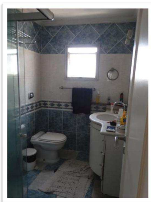
Foto nº 26 - Vista parcial interna do Apartamento nº 178 do Bloco B – Banheiro Social.
