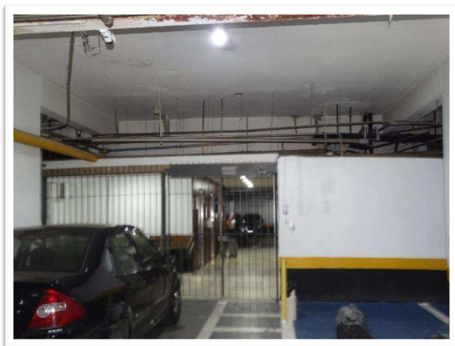
Foto nº 38 - Vista parcial do subsolo do Bloco B do Condomínio Prive Cidade Jardim – Hall dos elevadores.
