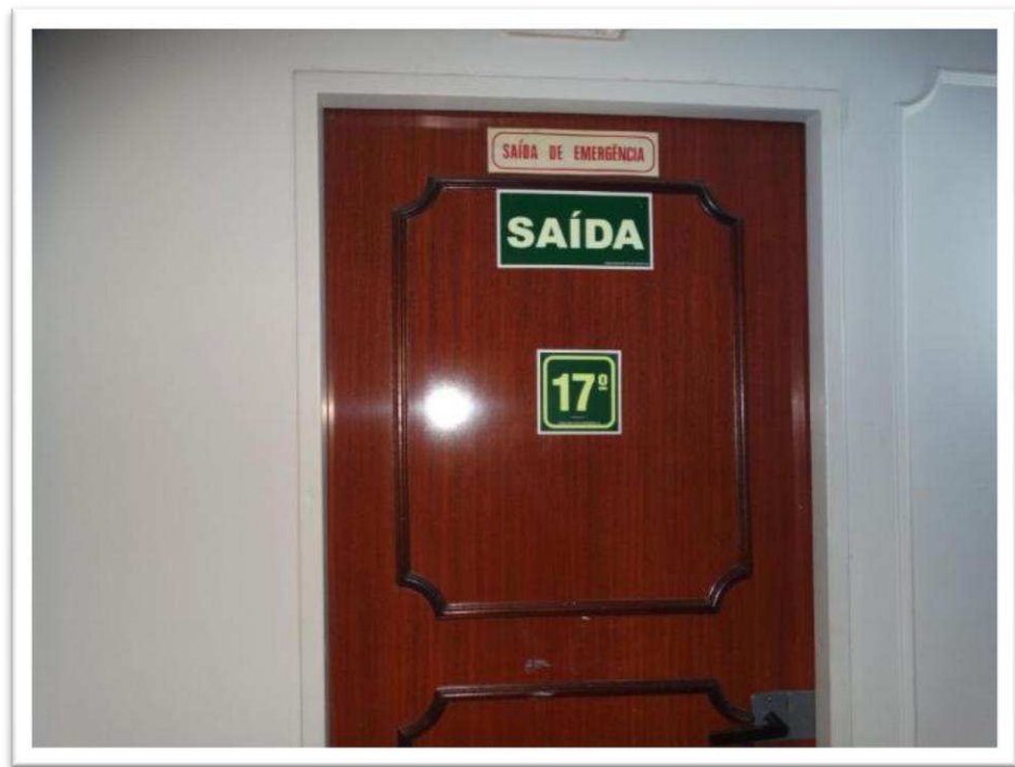
Foto nº 35 - Vista da porta da saída de emergência no 17º andar do Bloco B do Condomínio Prive Cidade Jardim.
