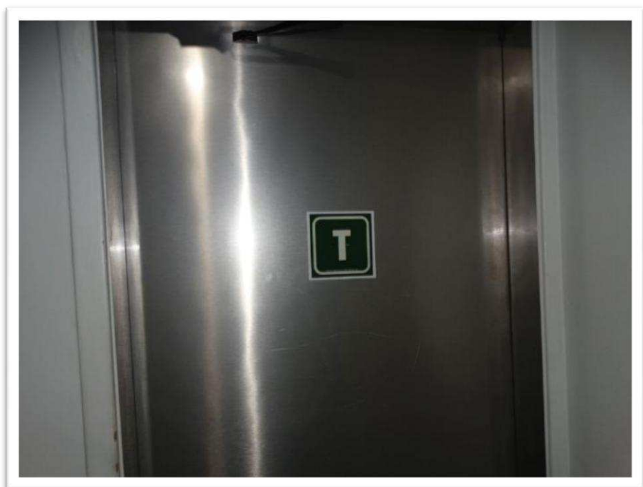
Foto nº 10 - Vista parcial do pavimento térreo do Bloco B do Condomínio Prive Cidade Jardim – Porta de Acesso à Antecâmara junto à caixa de escadas.
