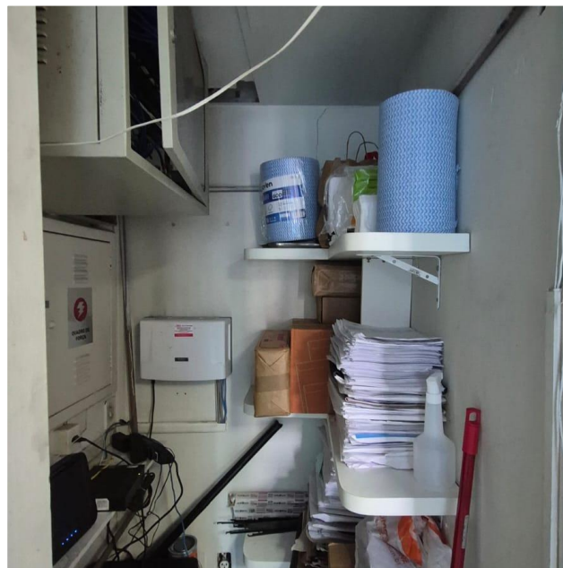
Foto 22 : Área de serviço - conjunto 121
