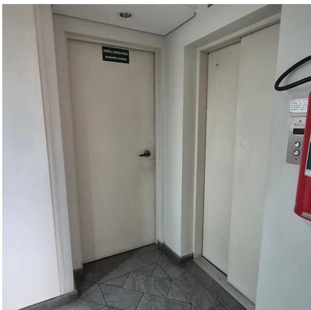
Foto 9: Hall dos elevadores.
