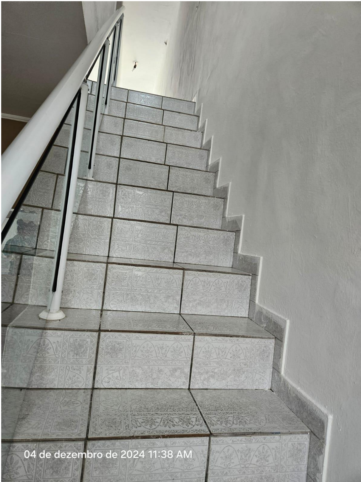
FOTO 15: ESCADA DE ACESSO AO SEGUNDO ANDAR
