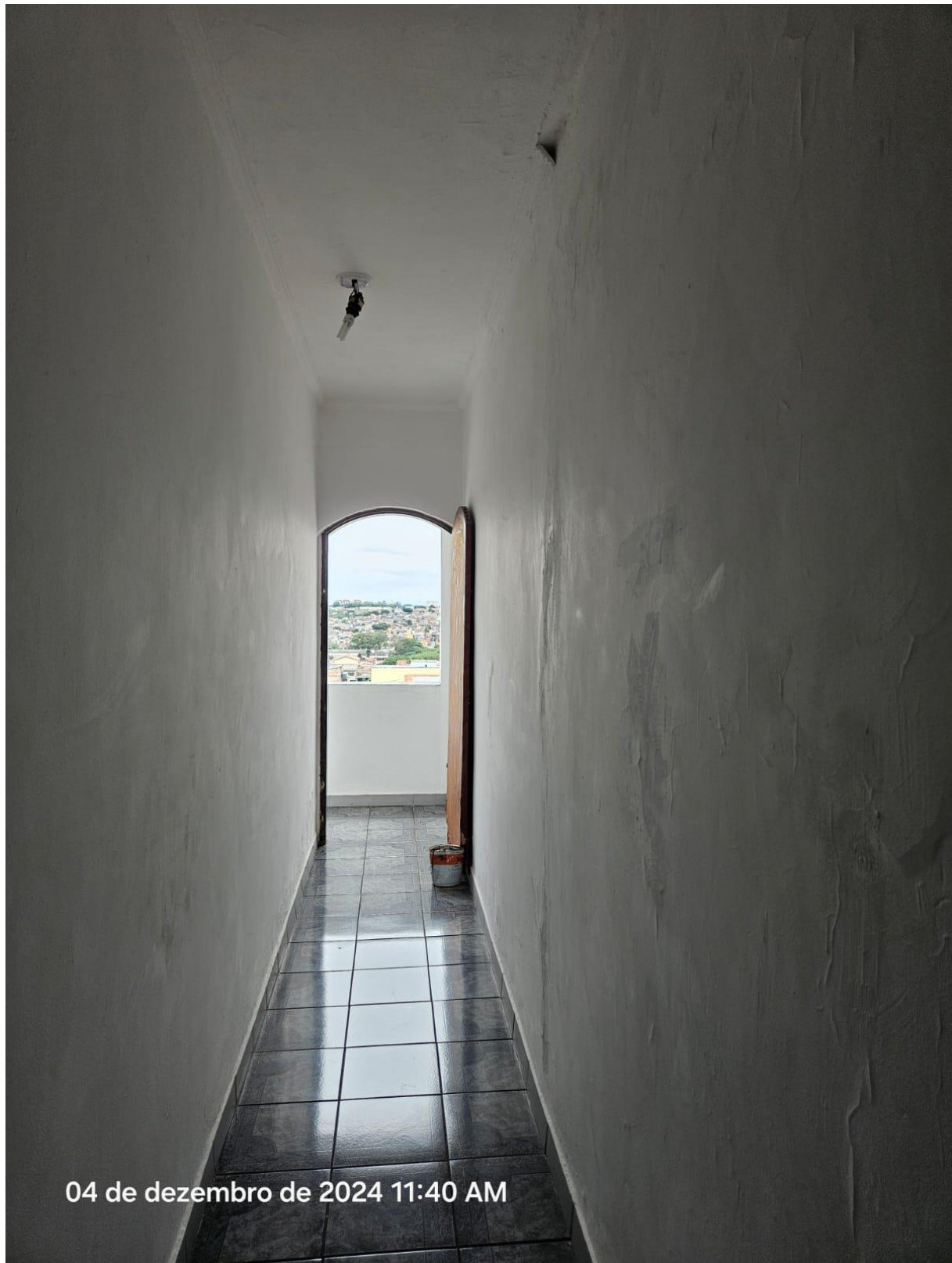
FOTO 16: CORREDOR – SEGUNDO ANDAR
