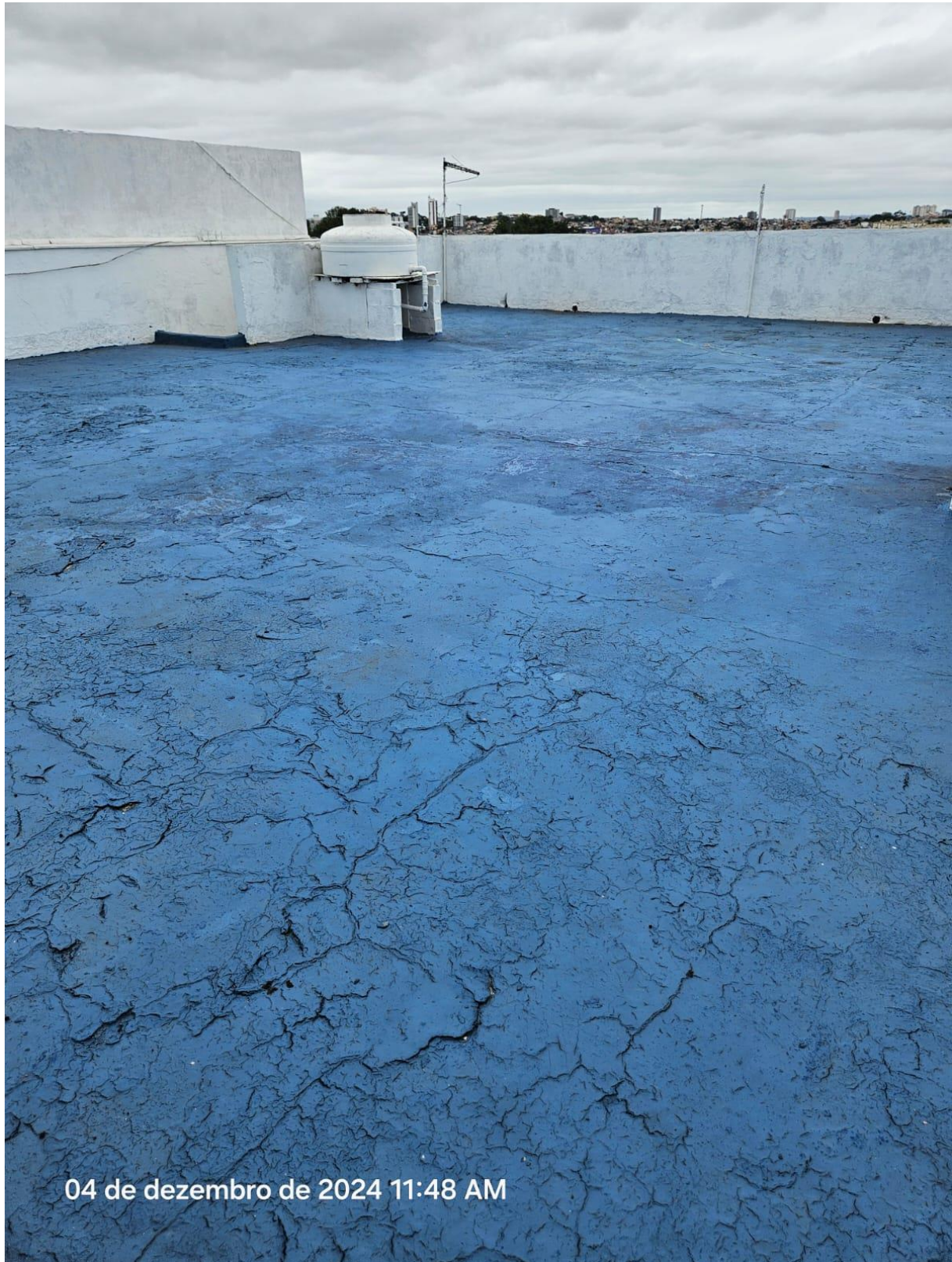
FOTO 25: LAJE DO IMÓVEL
