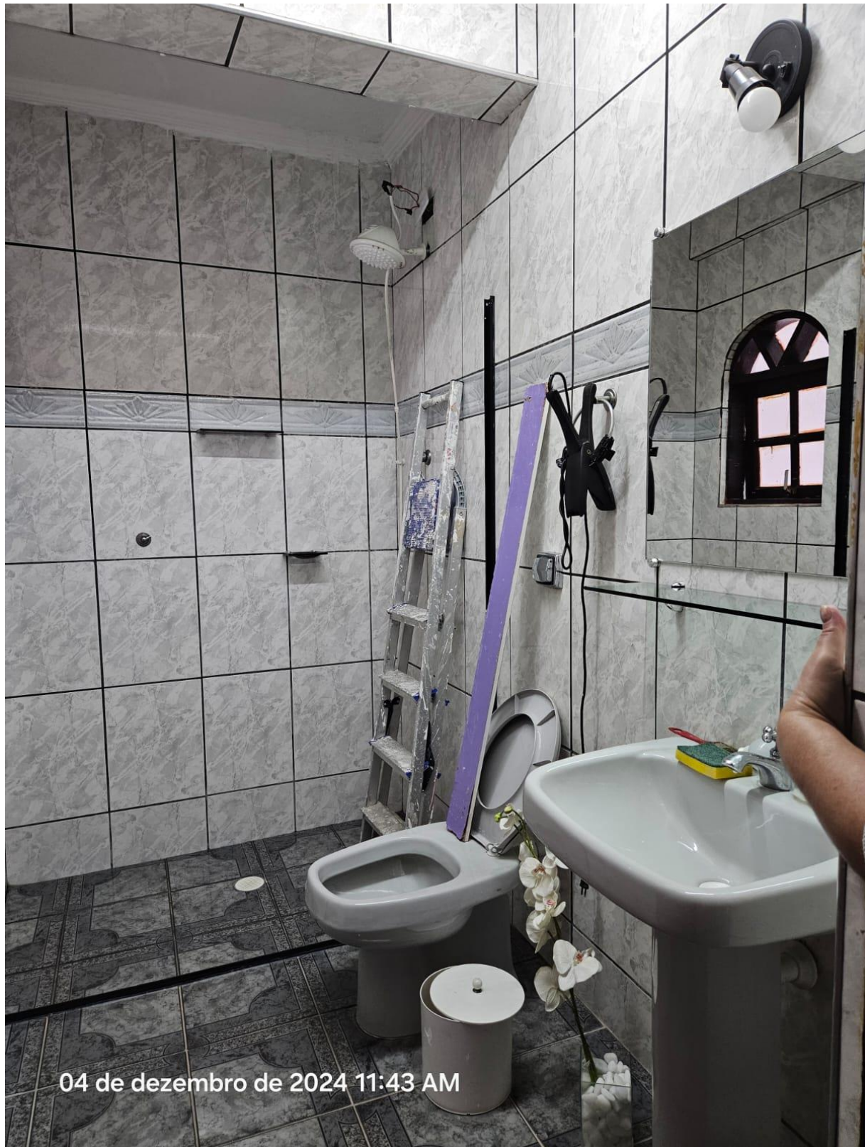
FOTO 22: BANHEIRO CORREDOR – SEGUNDO ANDAR
