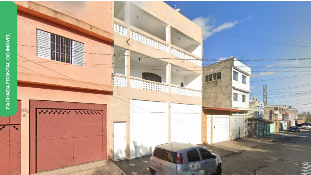
Fachada frontal do imóvel
